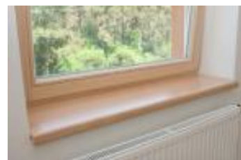
Parapet v interiéru
