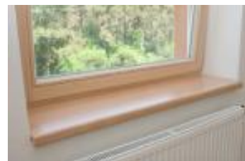
Parapet v interiéru
